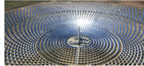
Die Gemasolar-aanleg in Spanje – 'n GSK-toringaanleg van 20 MW
